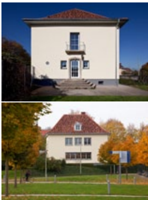
Das sanierte Gebäude in der Georges-Köhler-Allee 10; Fotos: Ingeborg F. Lehmann
