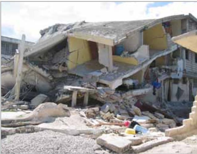
Zerstörtes Haus auf Haiti
